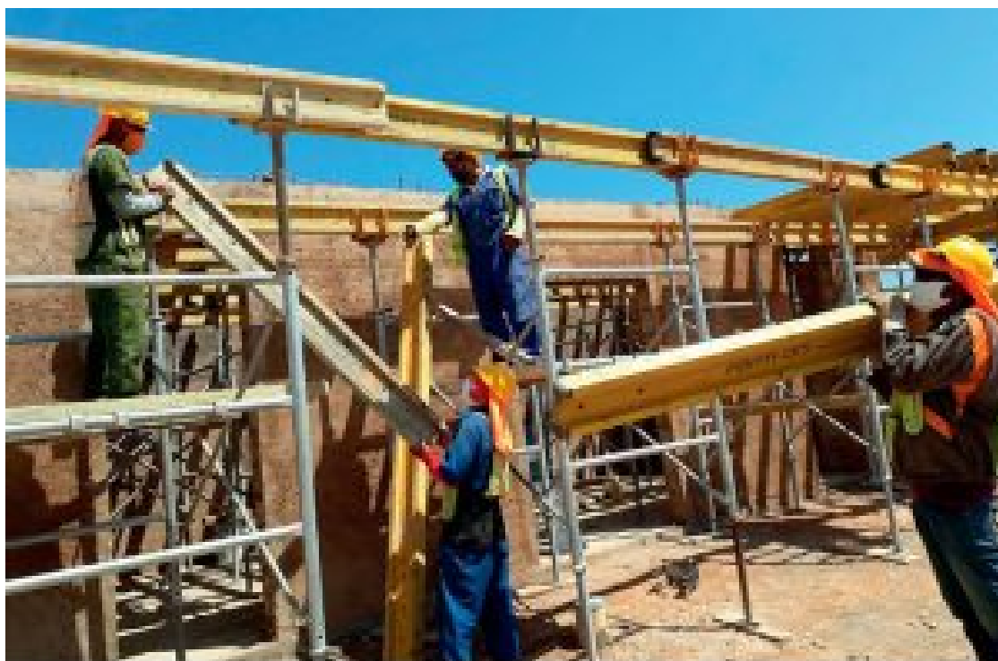
Bouwterrein voor een nieuw hotel in Varadero. Arbeidersmacht zorgt voor veilige werkomstandigheden
